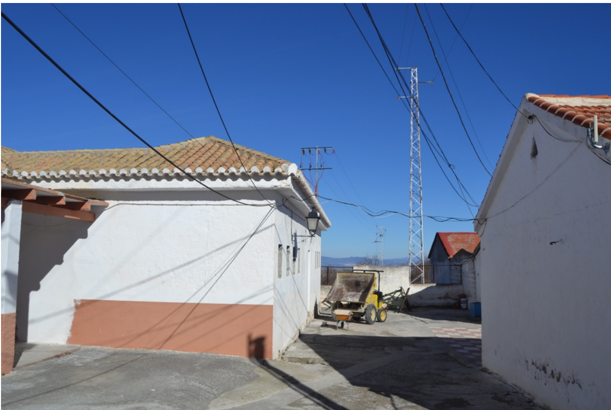
Fotografía 02. Estado actual del ámbito de intervención
